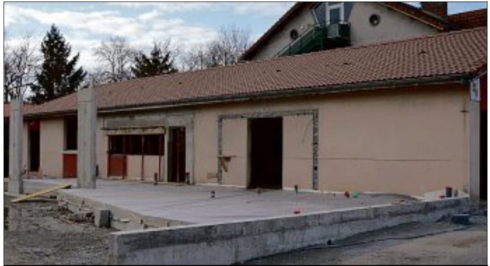
ÉCOLOGIQUE. Les travaux de la salle polyvalente de Dorat sont en cours pour une fin de chantier prévue à l'automne.
