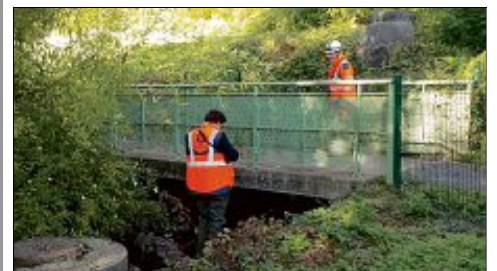
Une fois le diagnostic effectué, libre aux communes de faire les travaux préconisés.
